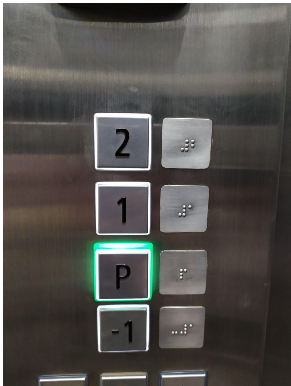
Obr. č. 15: Hmatové značení tlačítek.
