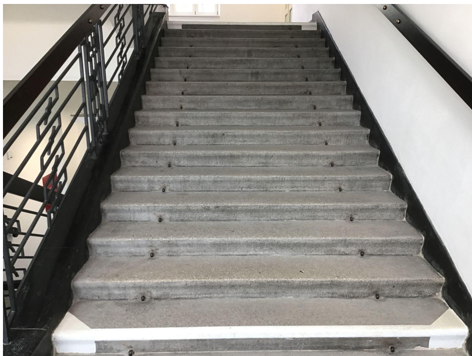
Obr. č. 5: Příklad označení prvního a posledního schodu – na tomto obrázku je však nesprávně částečně nabarvena i podstupnice
