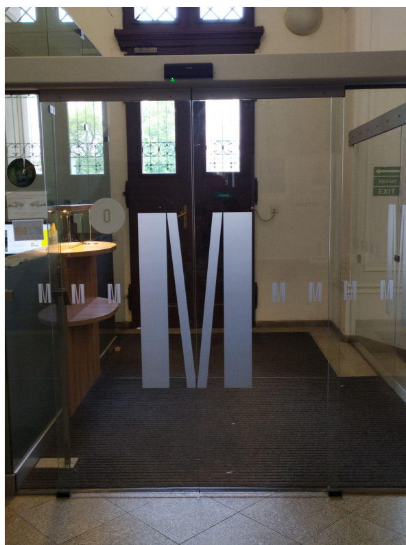
Obr. č. 8: Příklad alternativního vyznačení prosklené plochy.
