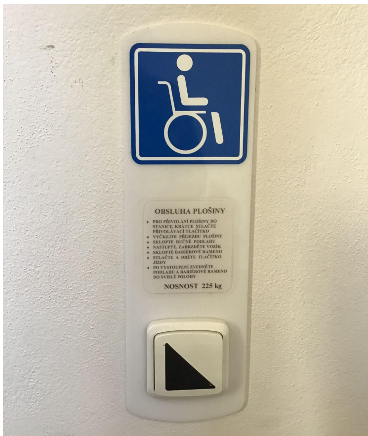
Obr. č. 13: Popis ovládání plošiny v nástupním bodě
