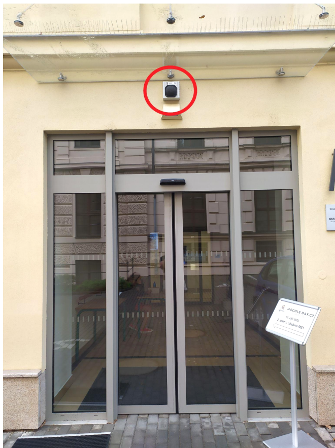
Obr. č. 2: Umístění majáčku nad vchodem do budovy v ose dveří.
